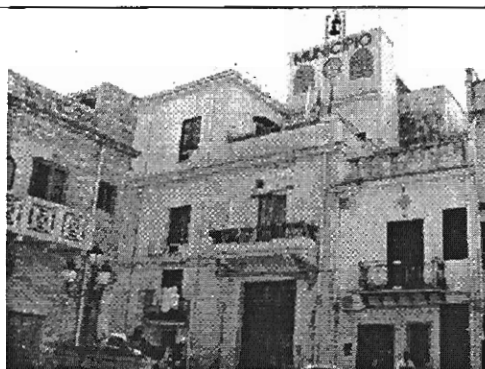
Prospetto su via Umberto I°
