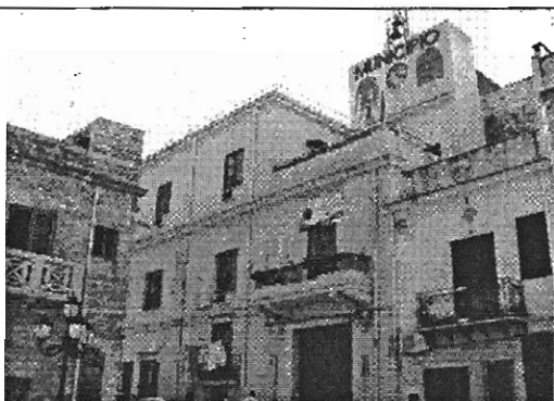
Prospetto su via Umberto I°
