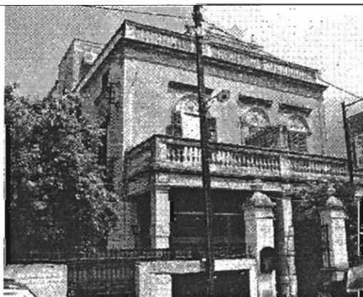
Prospetto su via Mons. Siino (SS. 113)
